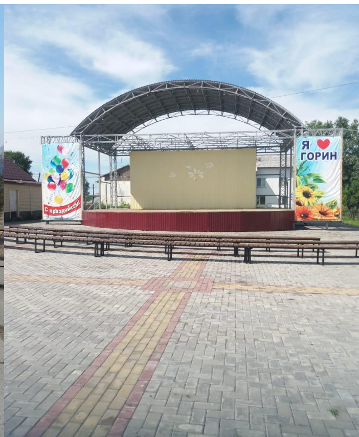
Фото "ход работ"
