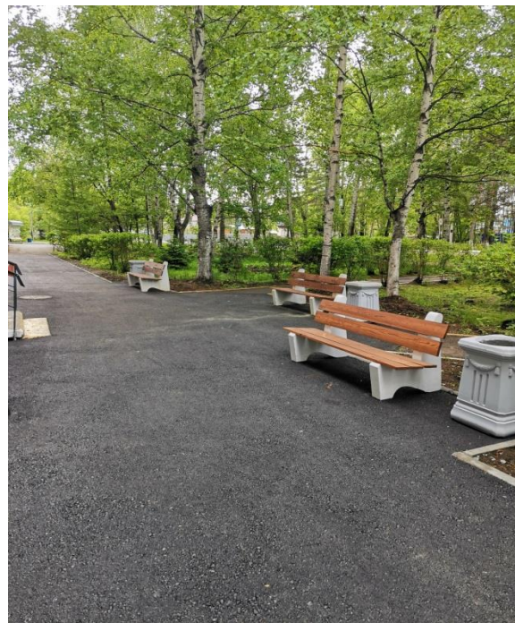
Фото "ход работ"
