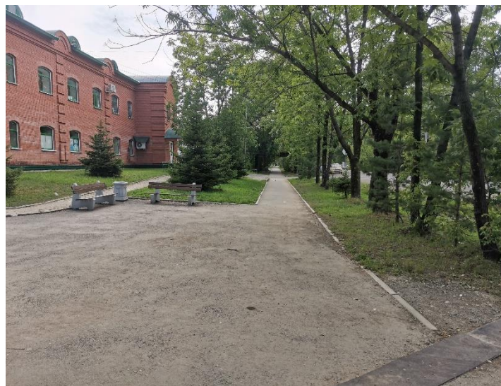
Фото "ход работ"
