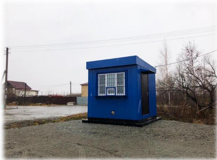
Введен водовод Гаровского водозабора (с. Гаровка-1, Хабаровский район)
